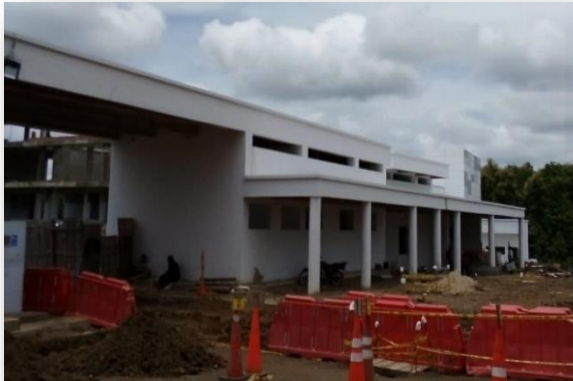
Bloque acceso control
